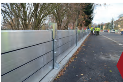
Protipovodňové hrzení, České Budějovice
